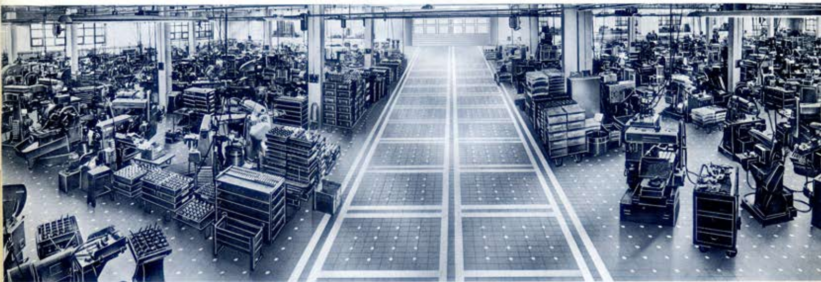
Un reparto di lavorazioni meccaniche
